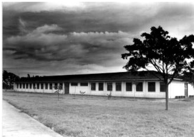
Figura 1.2 - BLOCO M05 - Face Sul no período de inverno. Sistema Construtivo com Bloco de Concreto e Telhamento Cerâmico
