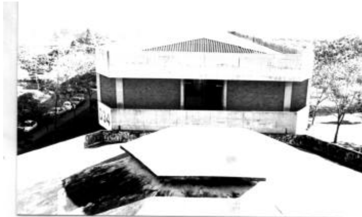
Figura 1.1 - BLOCO D34 - Face Nordeste à esquerda e Sudoeste à direita, no período de inverno. Sistema Construtivo com Bloco Cerâmico de 6 furos e Telhamento de Fibrocimento
