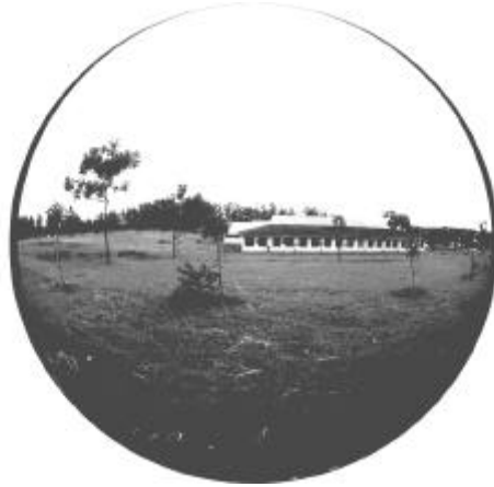
Figura III.1 - Bloco M05-Sala 07- Orientação N - Hemisfério horizontal externo dez/95.
