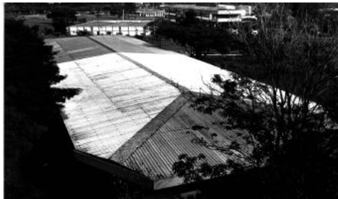
Figura 1.4 - BLOCO E34 - Face Sudeste à esquerda e Noroeste à direita no período de inverno. Sistema Construtivo com Bloco Cerâmico 4 furos e Telhamento em Alumínio
