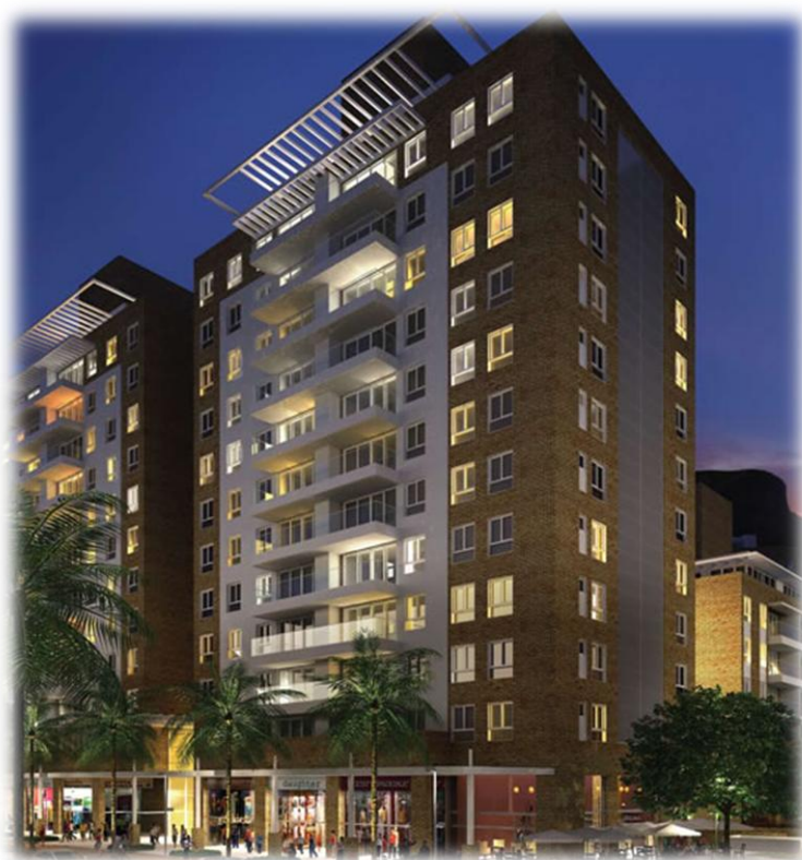
Figura 9: Edifício Travertino – Bloco A
